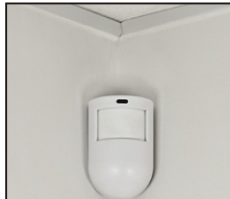
Installazione ad angolo Utilizzando solamente la base del DG12
